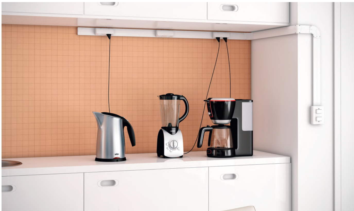
Canaleta sem tampa + Porta Equipamentos
