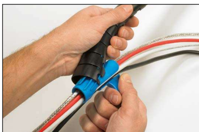
2) Encaixe o Helawrap na ferramenta de aplicação.
